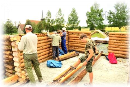
8. Укладка бревенчатых стен
