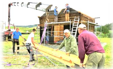
10. Установка центральной балки крыши
